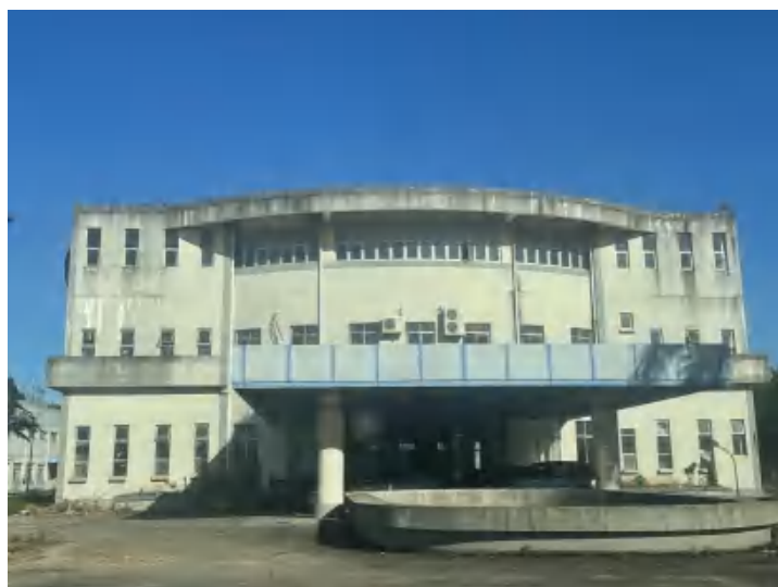
项目西南侧长泰精英运动用品有限公司空置办公楼
